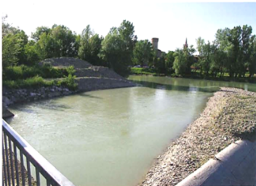
Canale di presa (derivazione dal ramo principale del Panaro) della centralina di Savignano al ponte di Vignola. (Foto Aquilino Richeldi)
