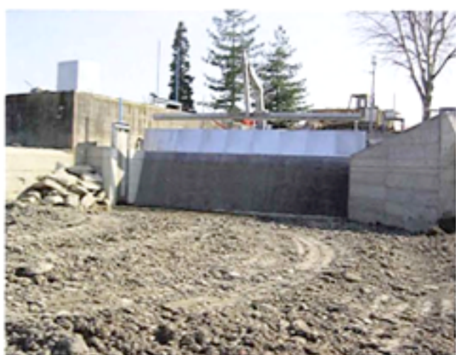
Canale di derivazione e sgrigliatore di Savignano Castiglione in costruzione. (Archivio Ditta Idro Panaro Energia Pura)
