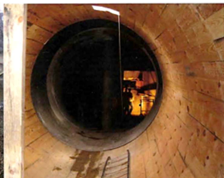
Canale di presa (derivazione dal ramo principale del Panaro) della centralina di Savignano al ponte di Vignola. (Foto Aquilino Richeldi)
