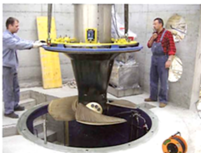
Collocazione in sito della turbina Kaplan nella centralina di S. Cesario. (Archivio Ditta Idro Panaro Energia Pura)
